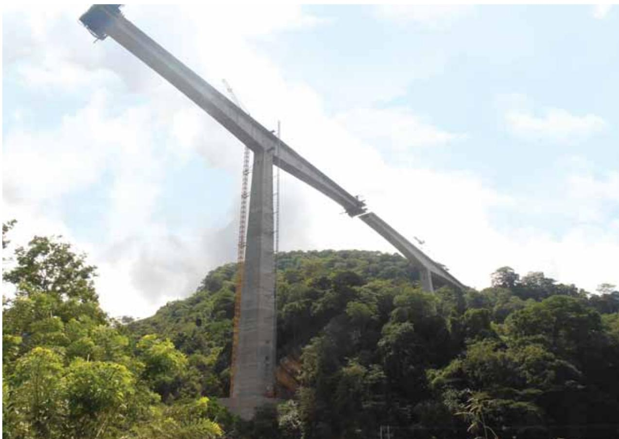
Fig 3. Vista de pila central Viaducto El Tablazo
